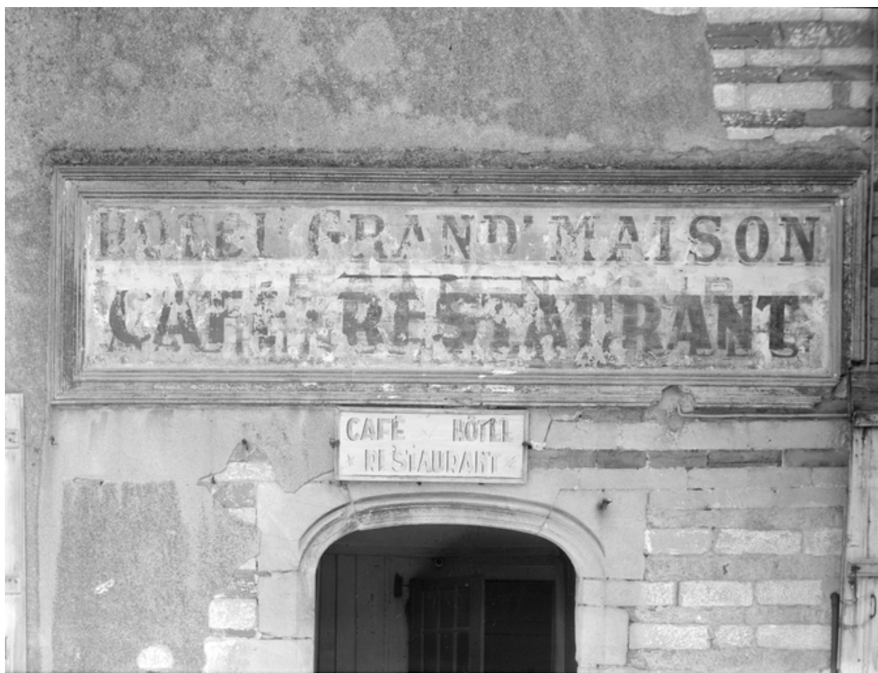
Linteau de la porte et appareillage du mur sur la façade sud-ouest.
