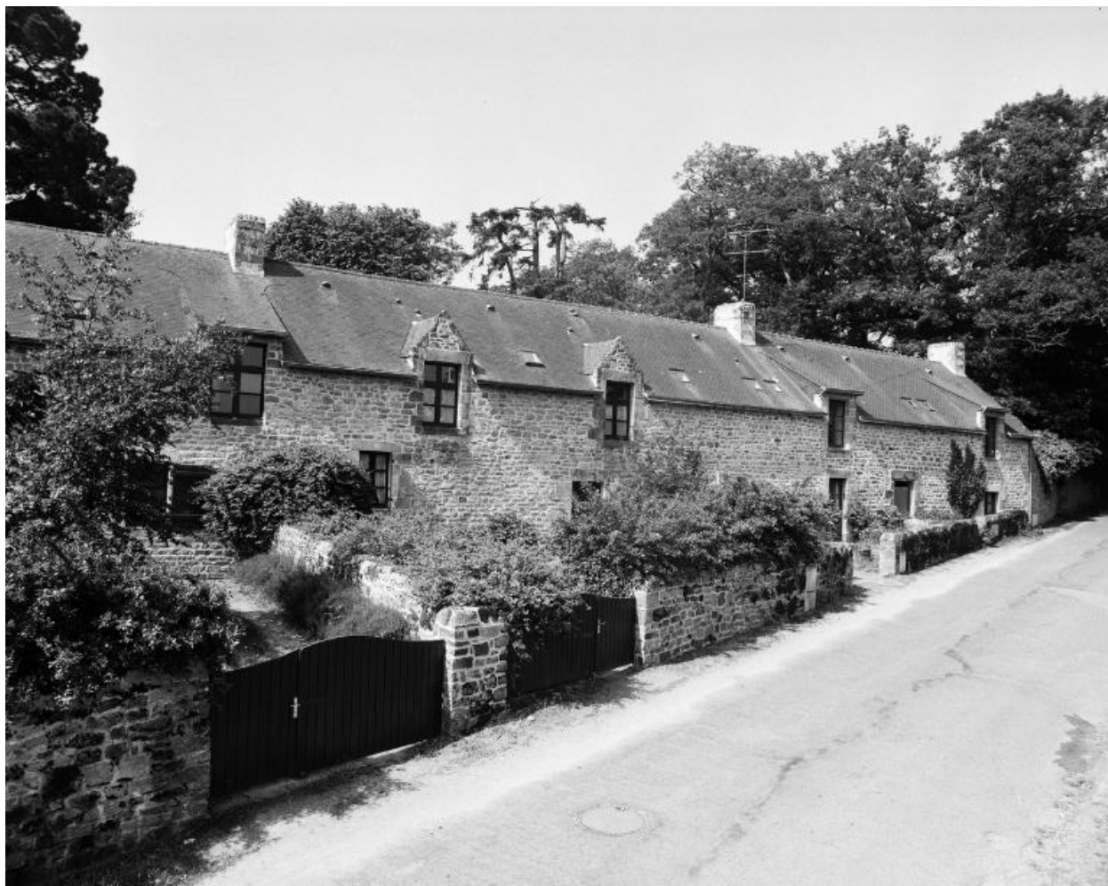
Ferme, élévation nord.
