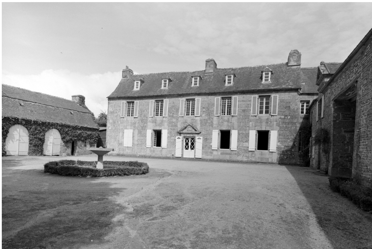
Aile ouest : élévation sud est
