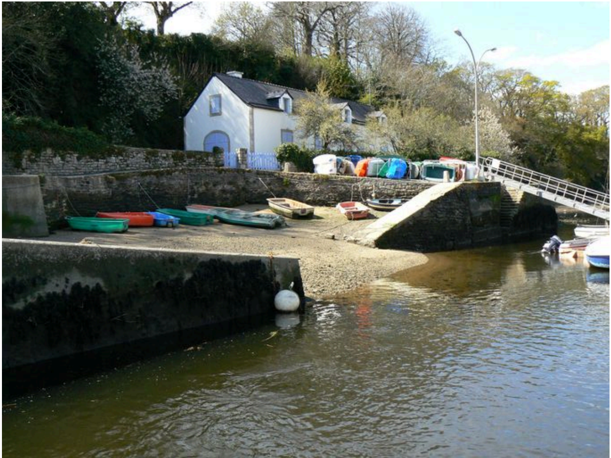
Vue générale du front portuaire du Pouldu
