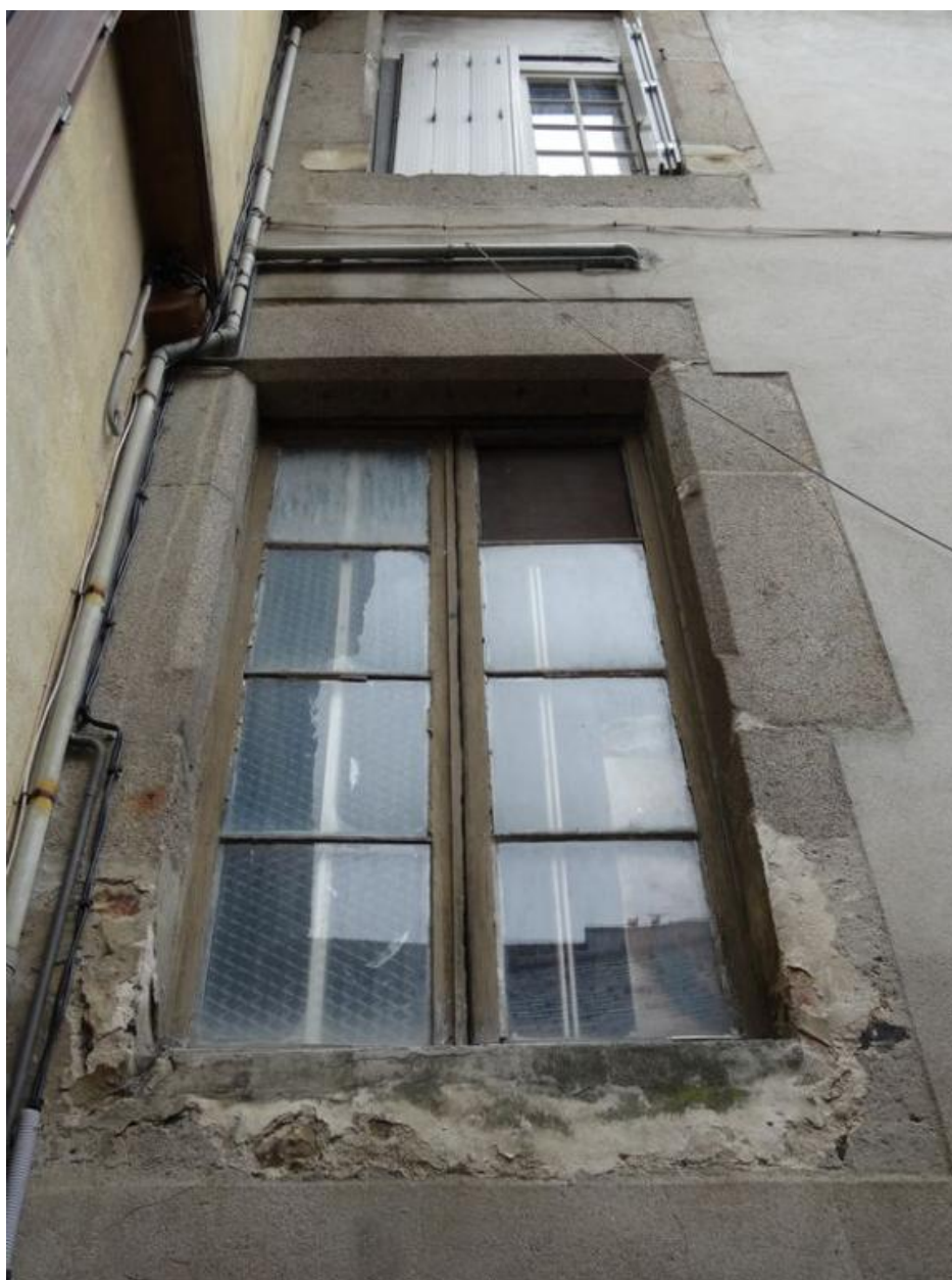
Fenêtre du rez-de-chaussée de la façade ouest
