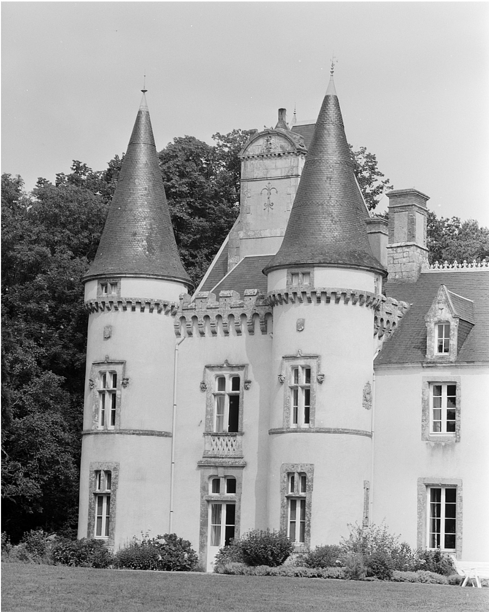
Elévation sud, partie ouest, vue sud-est.
