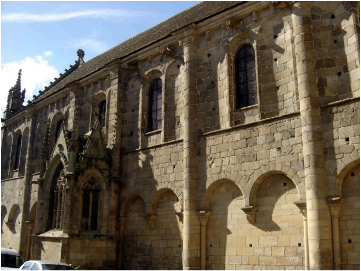
Elévation Sud, vue vers l'Ouest
