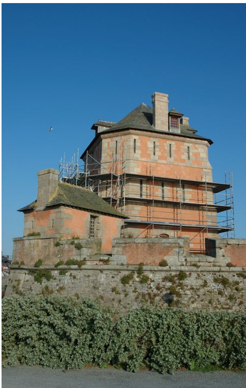
Vue de la Tour Vauban en restauration (mai 2007)
