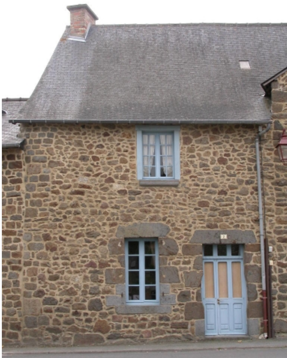
Vue générale nord
