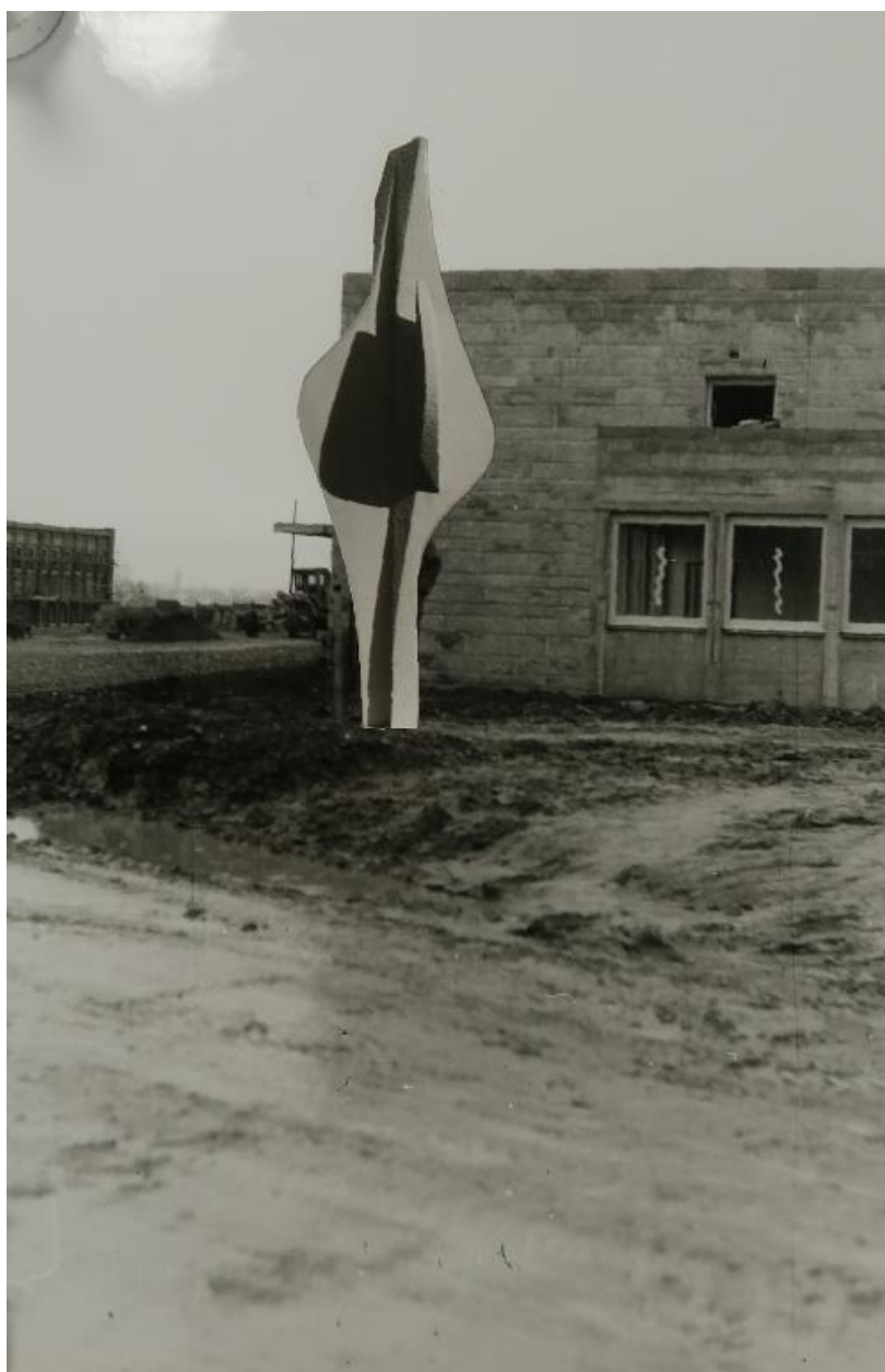
Francis Pellerin, maquette d'une sculpture (non réalisée), devant l'administration en chantier du lycée technique de Fougères, ca. 1968.
