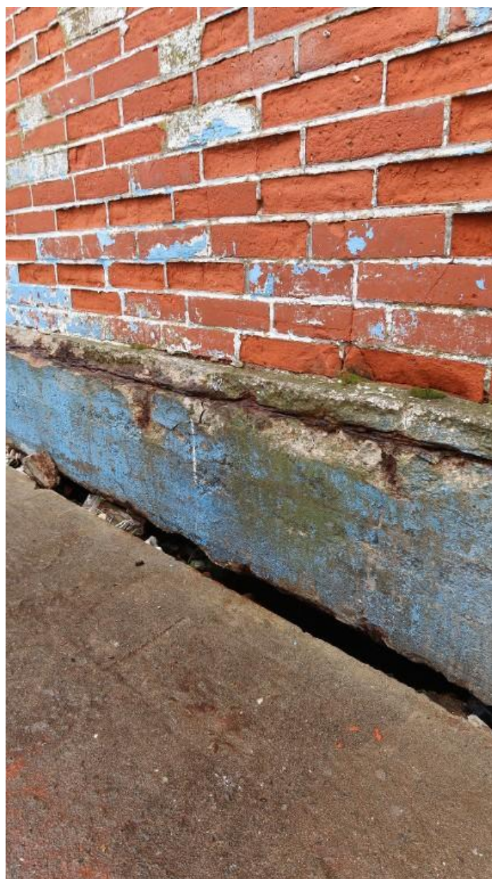
Jonction entre quai et mur de la criée 1
