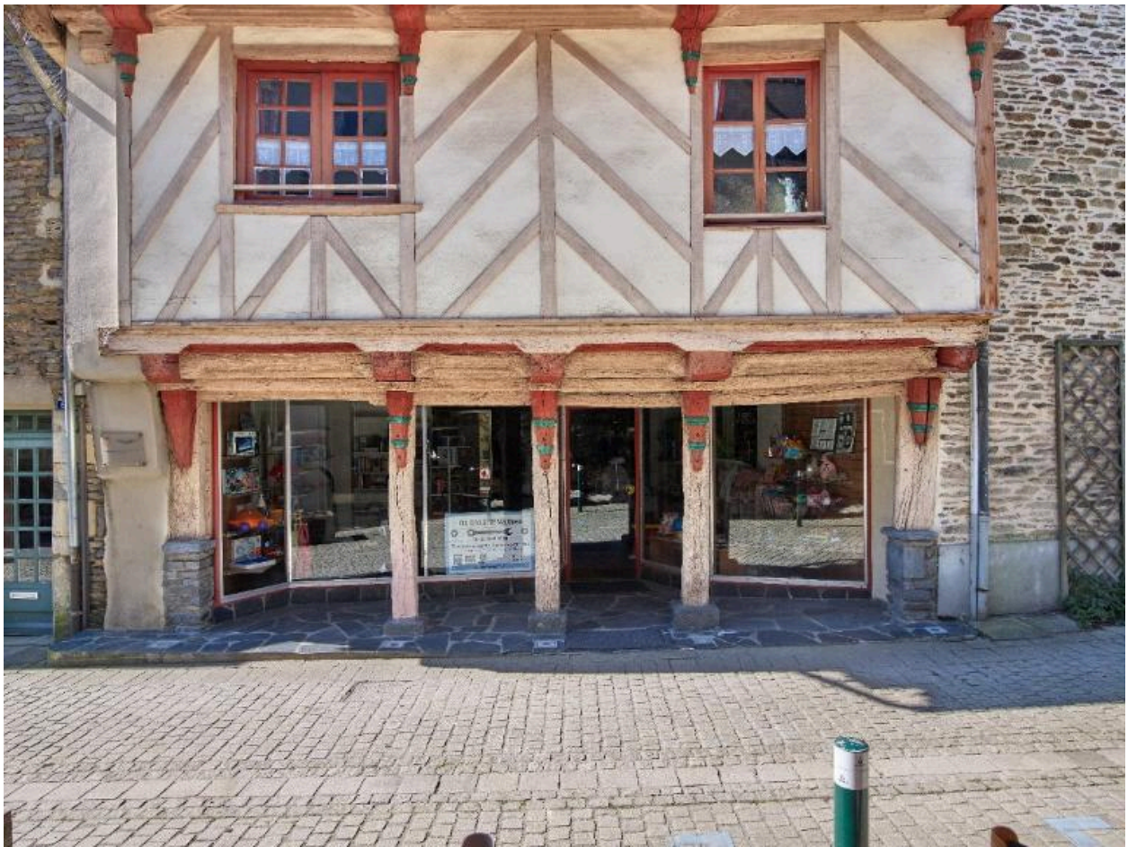
Maison en pan de bois à gouttereau sur rue, fortement remaniée.
