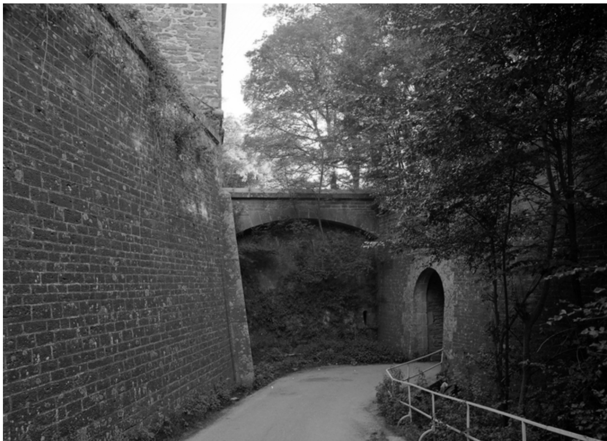
Le Palais, enceinte urbaine, porte de Locmaria, côté campagne, état dans les années 1970.
