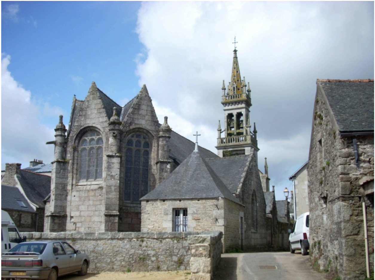
Huelgoat, église paroissiale Saint-Yves : vue générale nord-est
