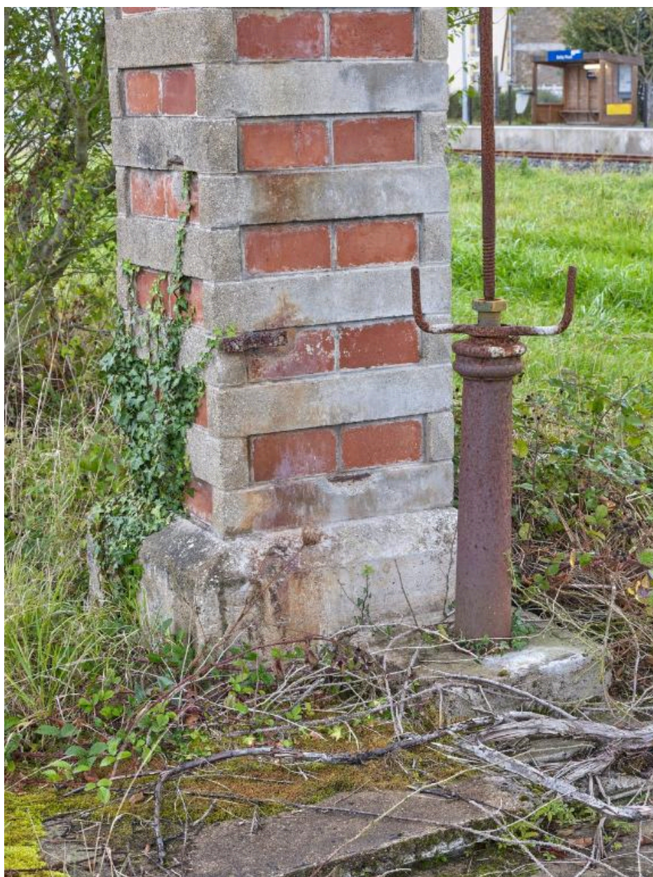
Gare de Brélidy-Plouër : détail pile du réservoir d'eau (béton, brique)
