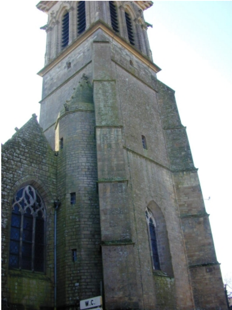
La tour bâtie en 1552 : vue générale nord-ouest
