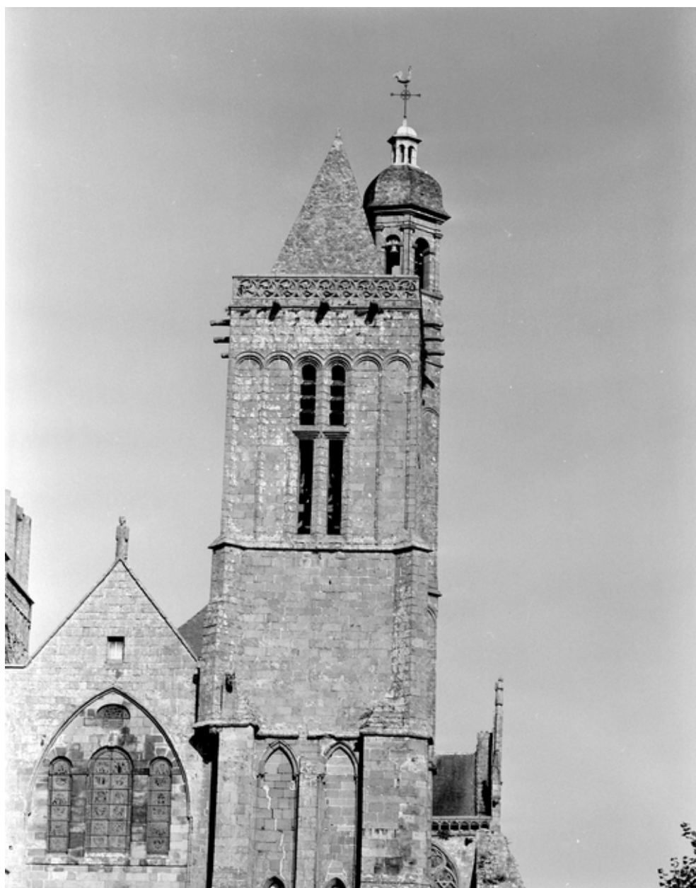
Tour occidentale sud : détail
