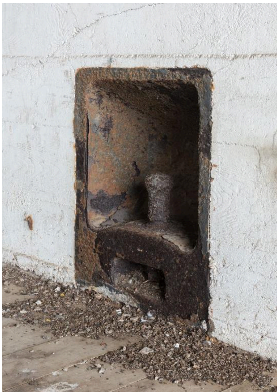
Vue de l'alvéole G (n° 13 et 14) : quai est n° 13, bollard ou borne d'amarrage intégré dans le mur
