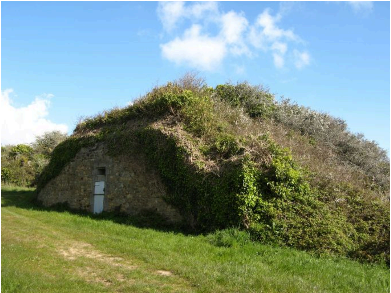
Elément de la batterie de Pont-Scorff
