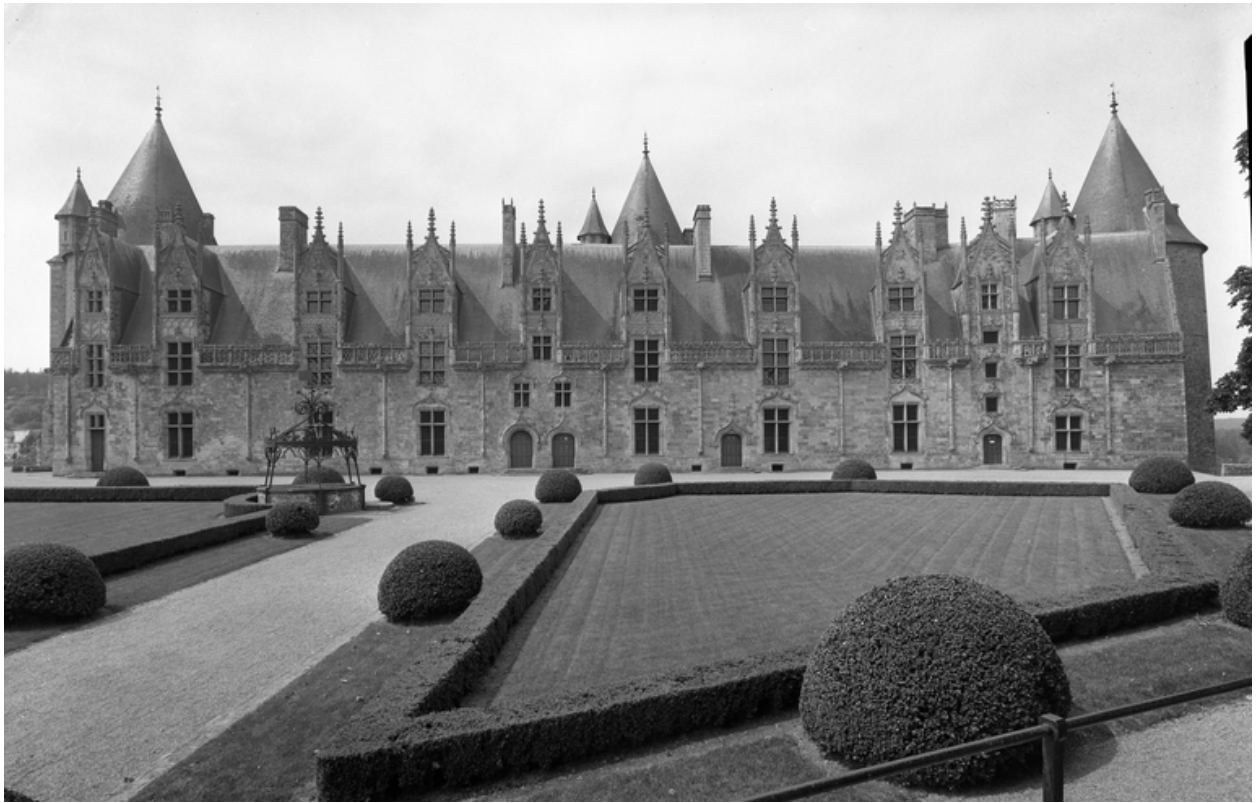
Logis, élévation sur cour : vue générale
