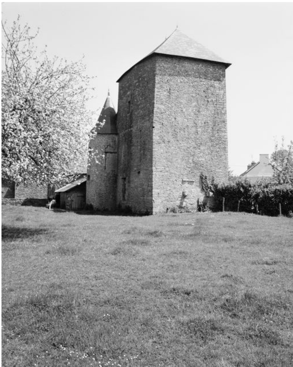
Manoir, vue générale nord-ouest.
