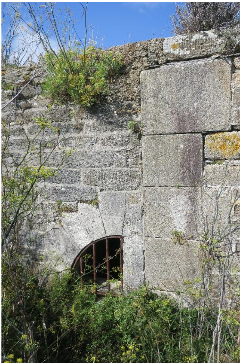
Le Palais, pointe de Taillefer, corps de garde crénelé, détail du raccordement à l'enceinte de la batterie de 1882.
