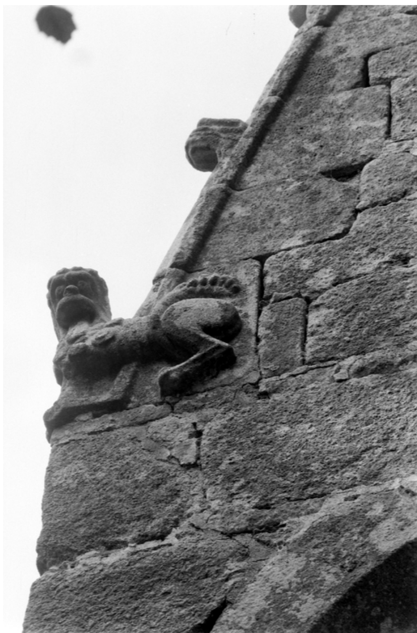
Mur est du bras nord : détail de la pierre d'assise du rampant
