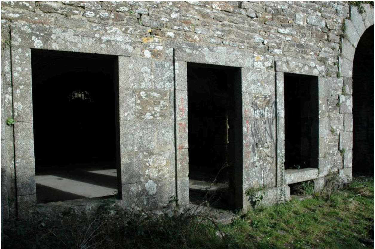
Vue des ouvertures de la chambrée de soldats nord (état en 2006)
