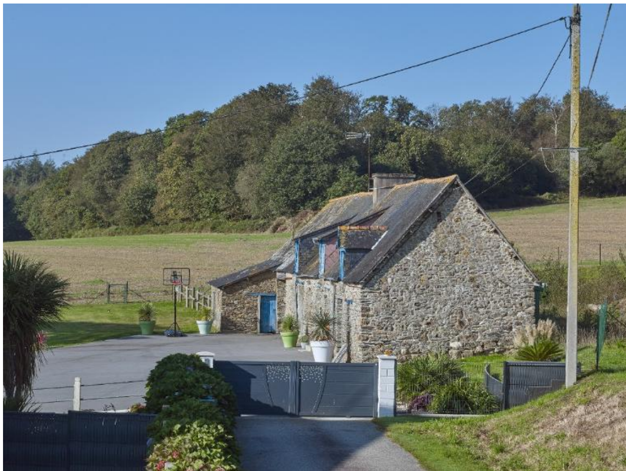
Alignement. Vue de situation sud-est
