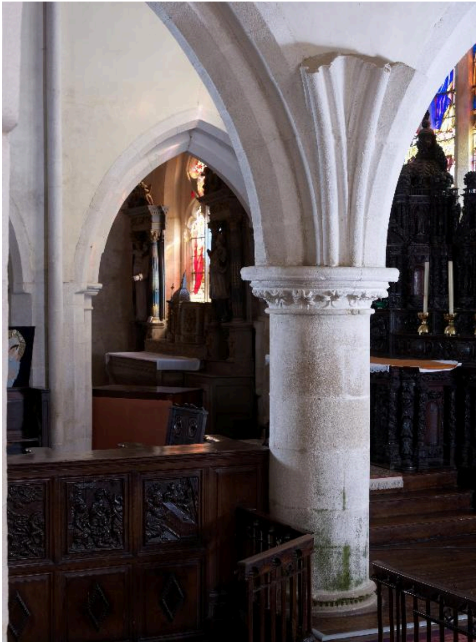
Chapelle sud. Détail d'un pilier et d'un départ de voûte
