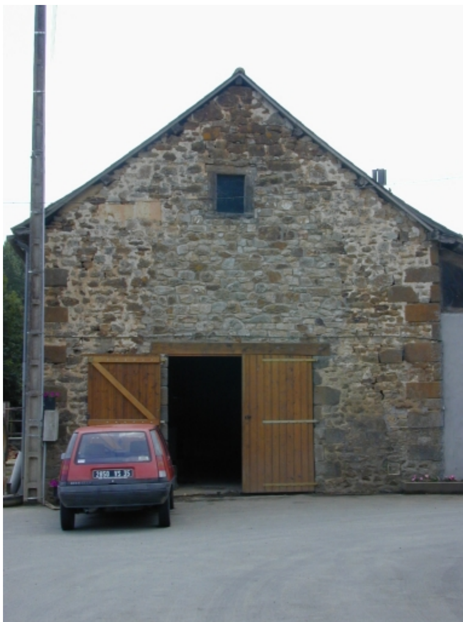
Orangerie : pignon est
