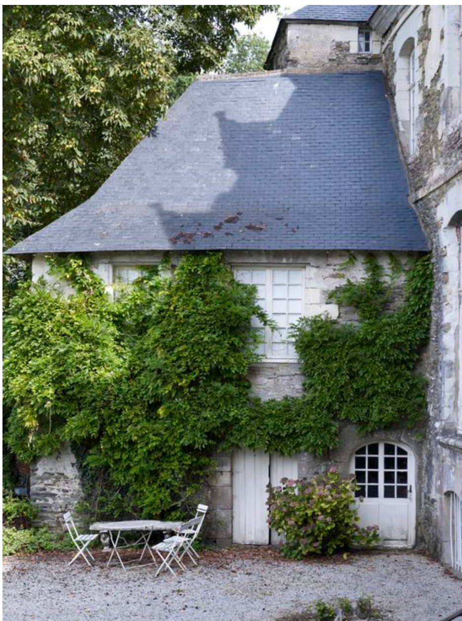
Château, logis, aile nord-ouest : vue générale prise du nord-ouest (état en 2010)
