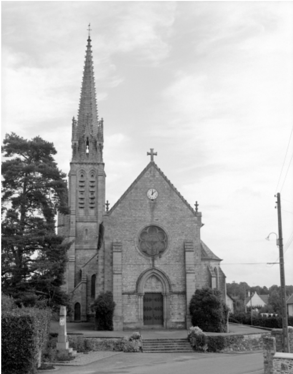
Vue générale ouest.
