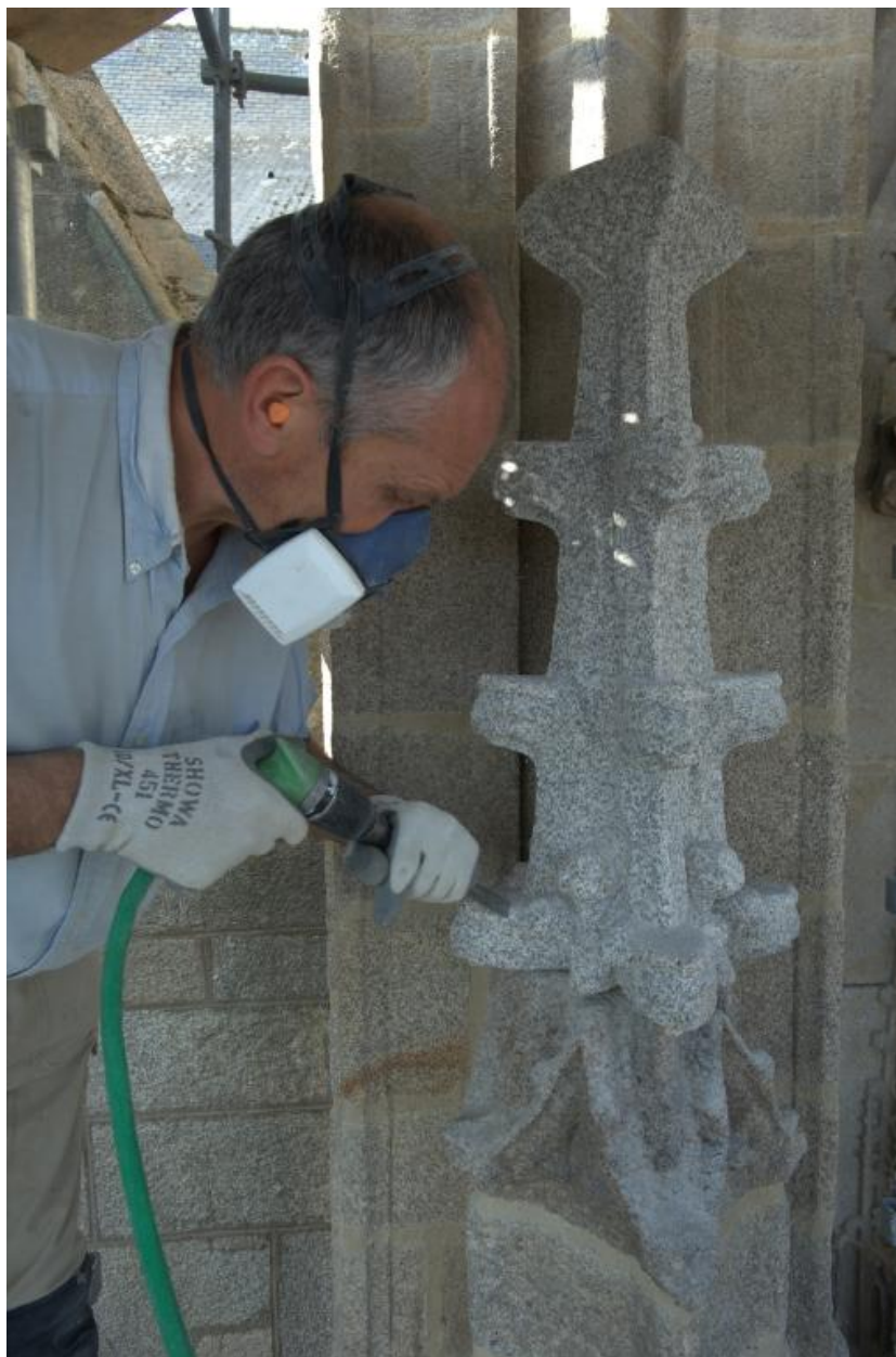
Portail nord, restauration d'un pinacle
