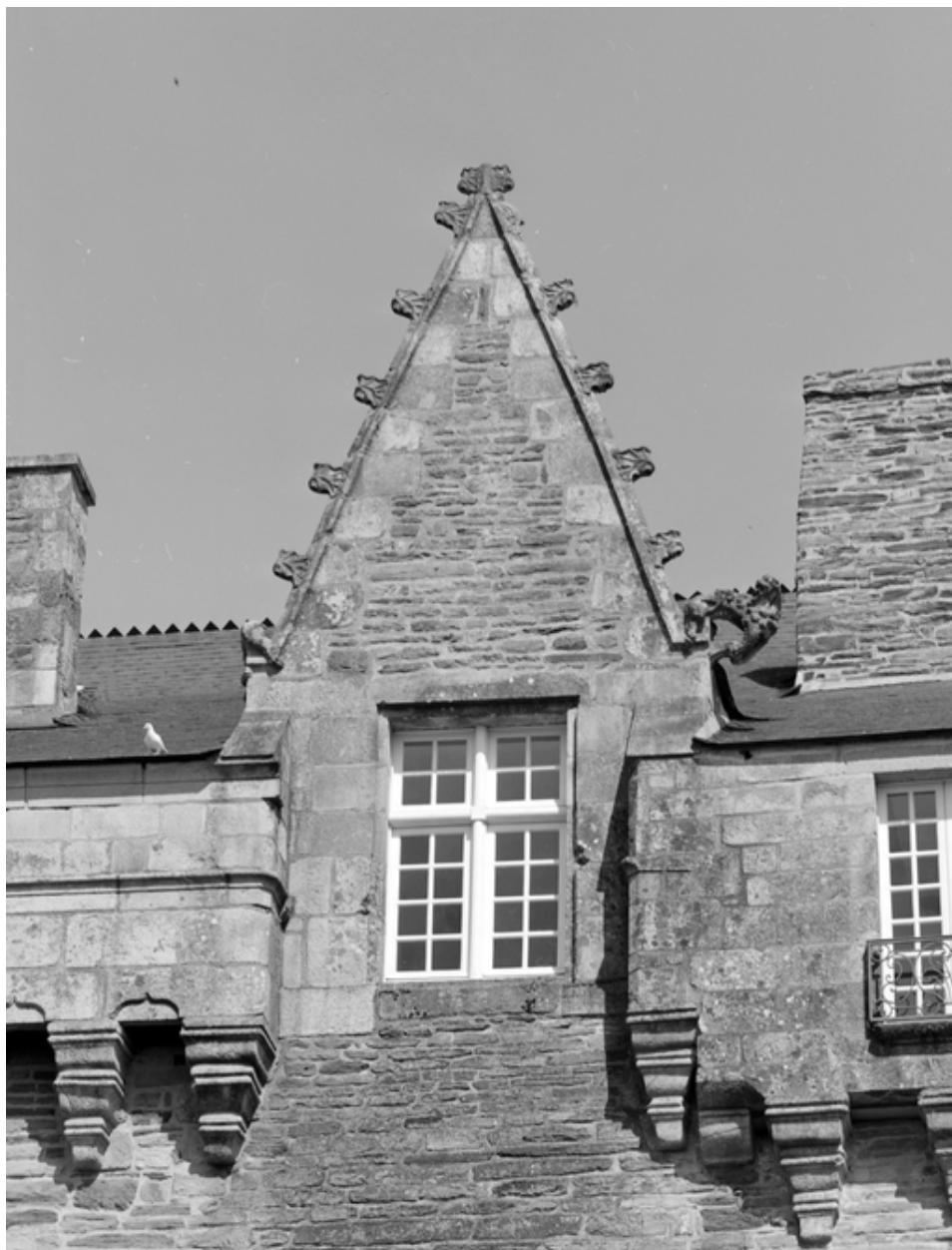
Aile ouest, première lucarne à partir du nord.
