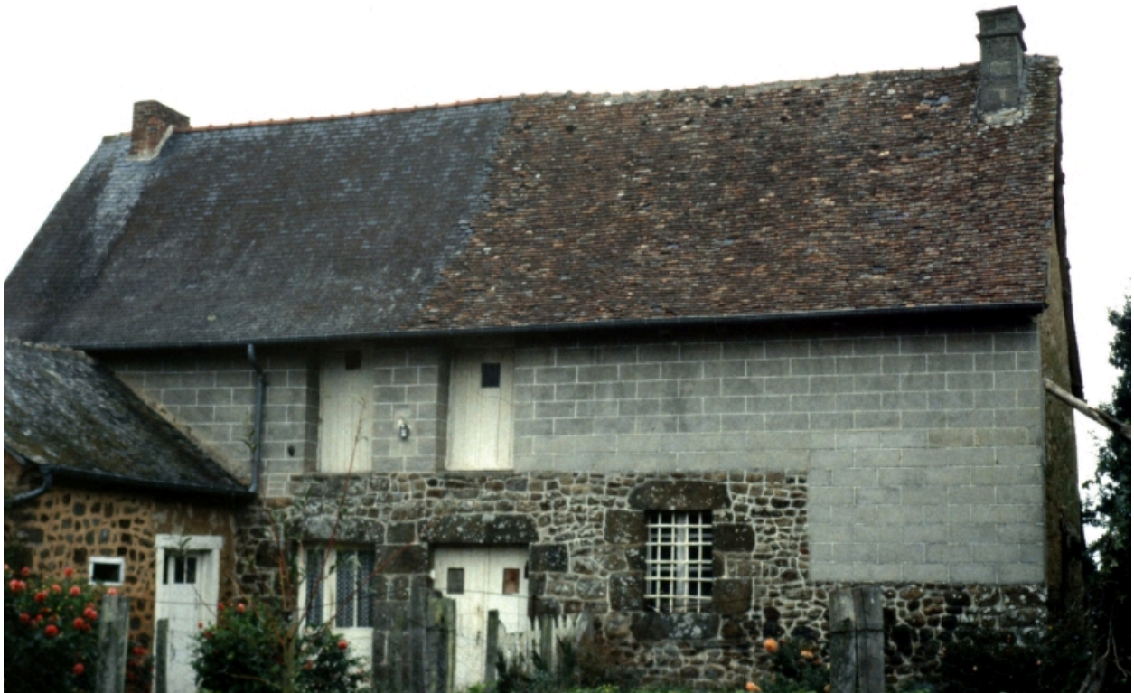
Croix chemin, ferme : élévation sud
