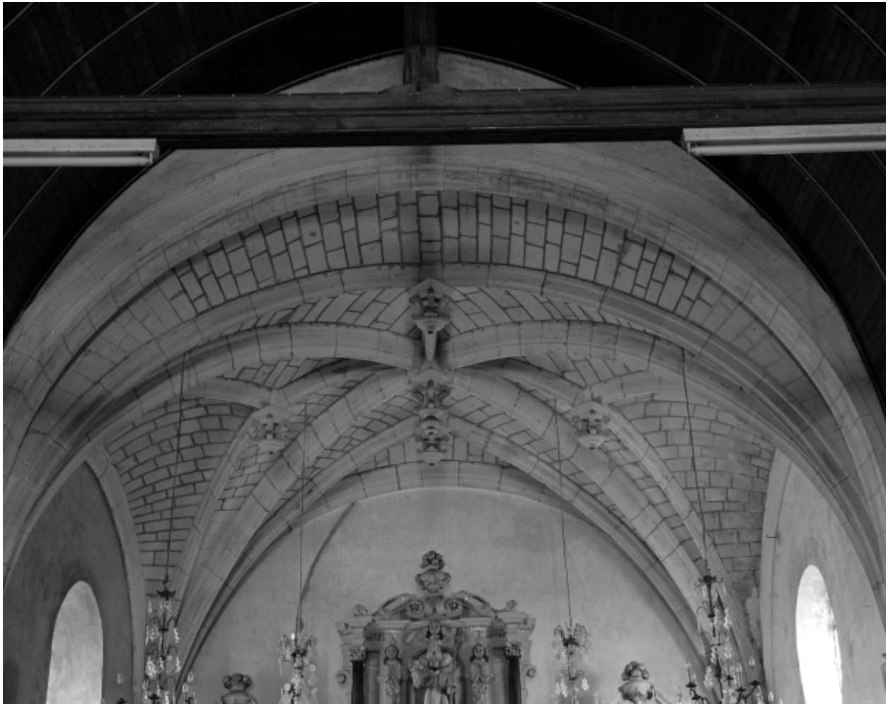
Voûte du choeur, vue générale.
