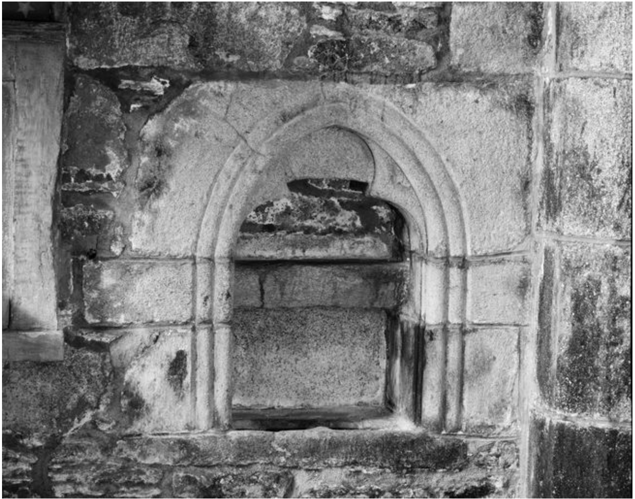
Chapelle, bras nord du transept : la niche-crédence (état en 1992)
