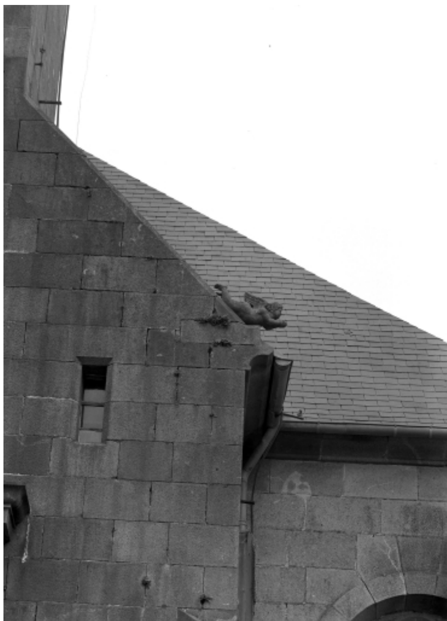
Port-Launay, église paroissiale Saint-Nicolas : façade ouest, détail crossette sculptée, état en 1972
