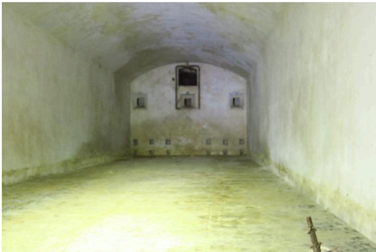
Le Palais, enceinte urbaine, magasin à poudre, chambre de stockage.
