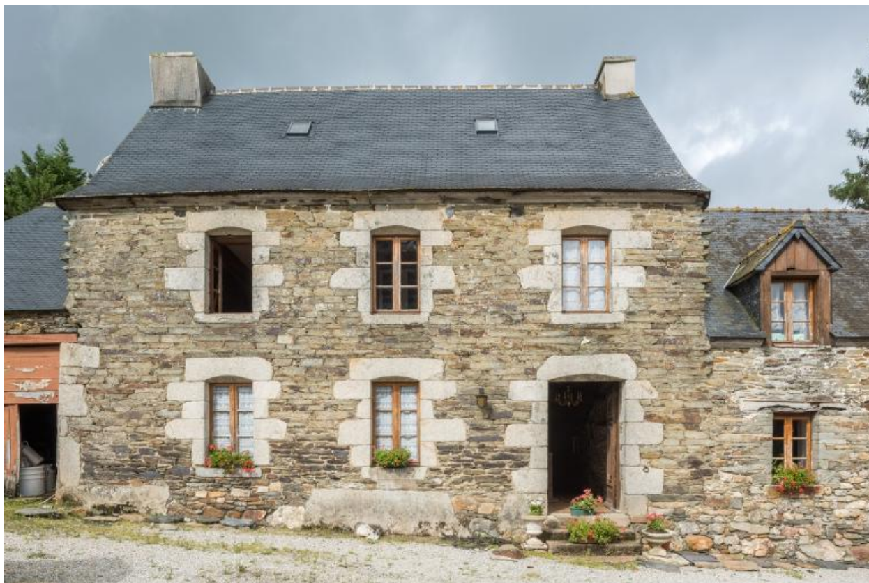
La Ville-au-Chevalier. Maison de marchand de toiles, 1774. Elévation sud
