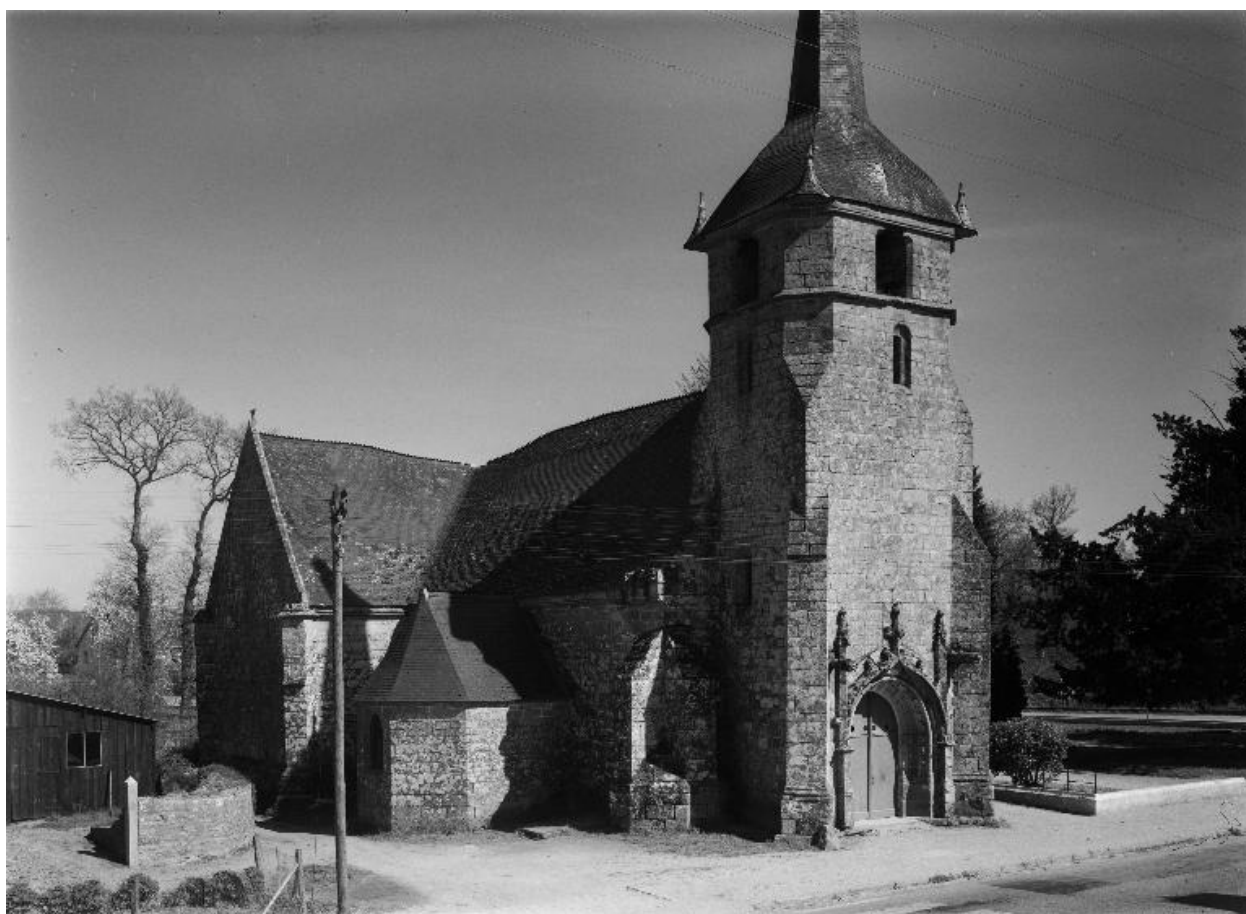
Vue de situation prise du nord-ouest
