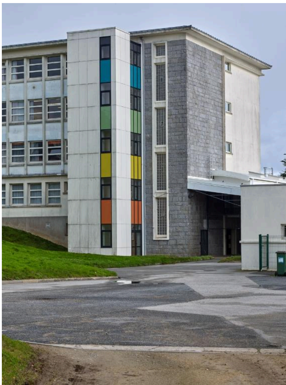
Angle sud-ouest de l'externat du lycée et son extension colorée pour mise aux normes d'accessibilité.
