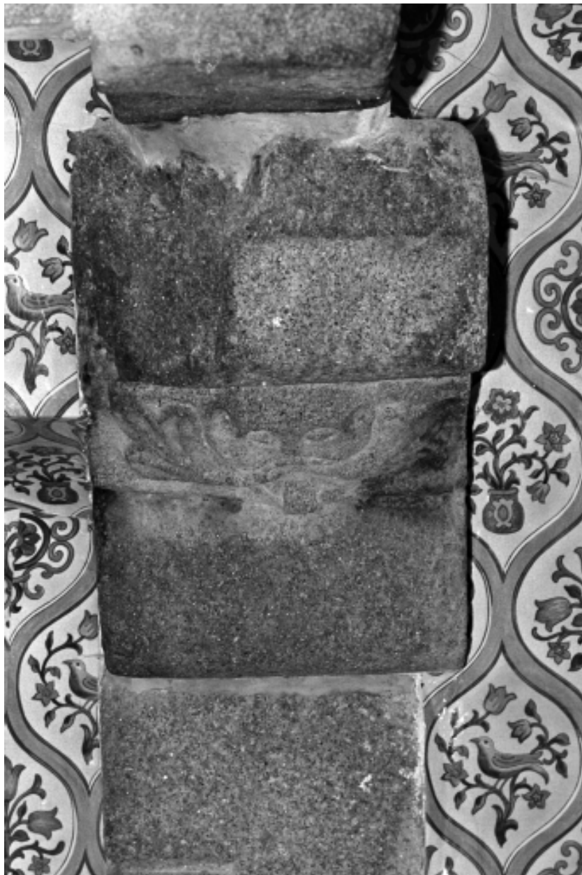
Cheminée du rez-de-chaussée, détail du visage sur le corbeau
