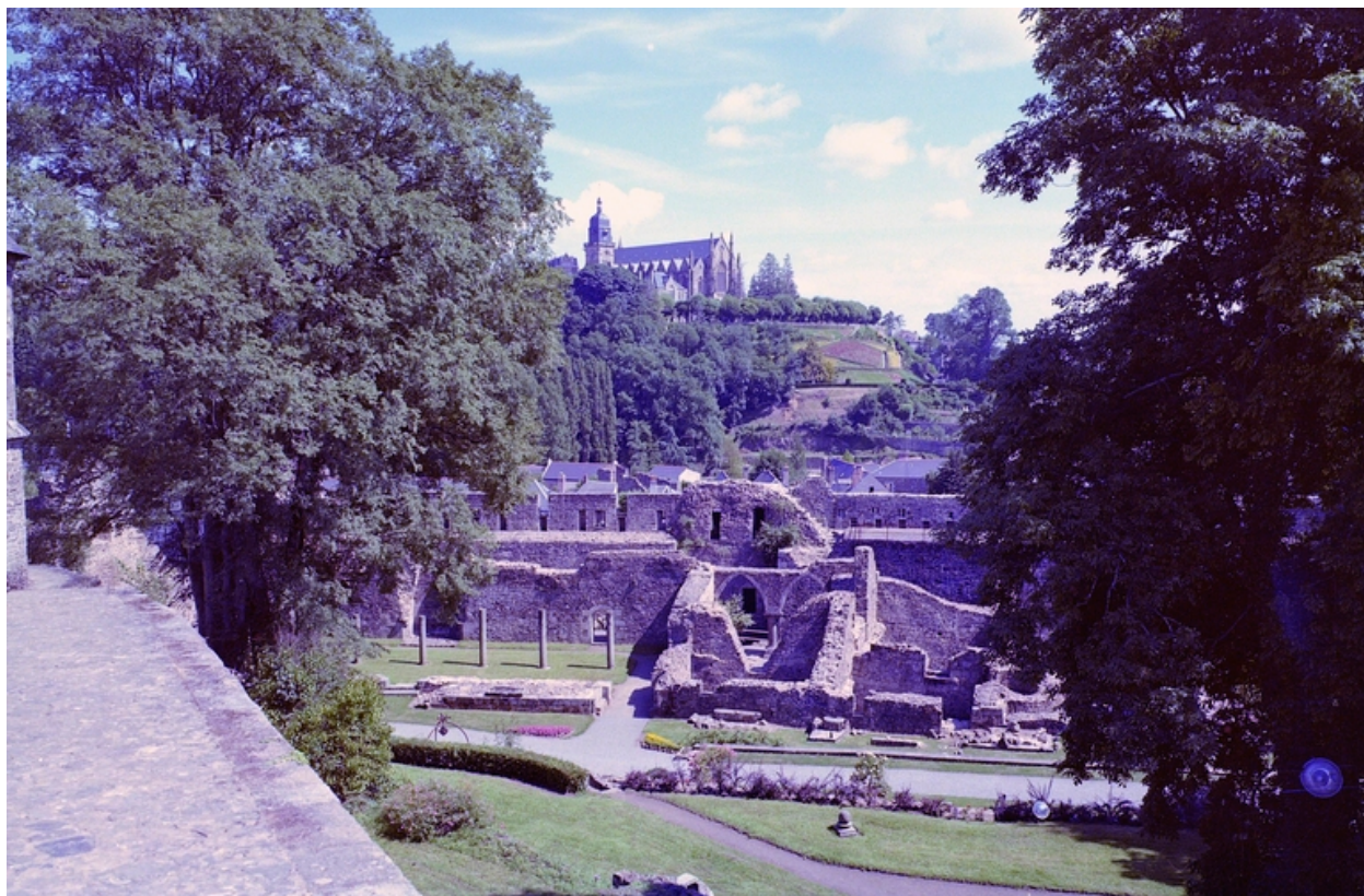
Ancien logis, vue générale nord.
