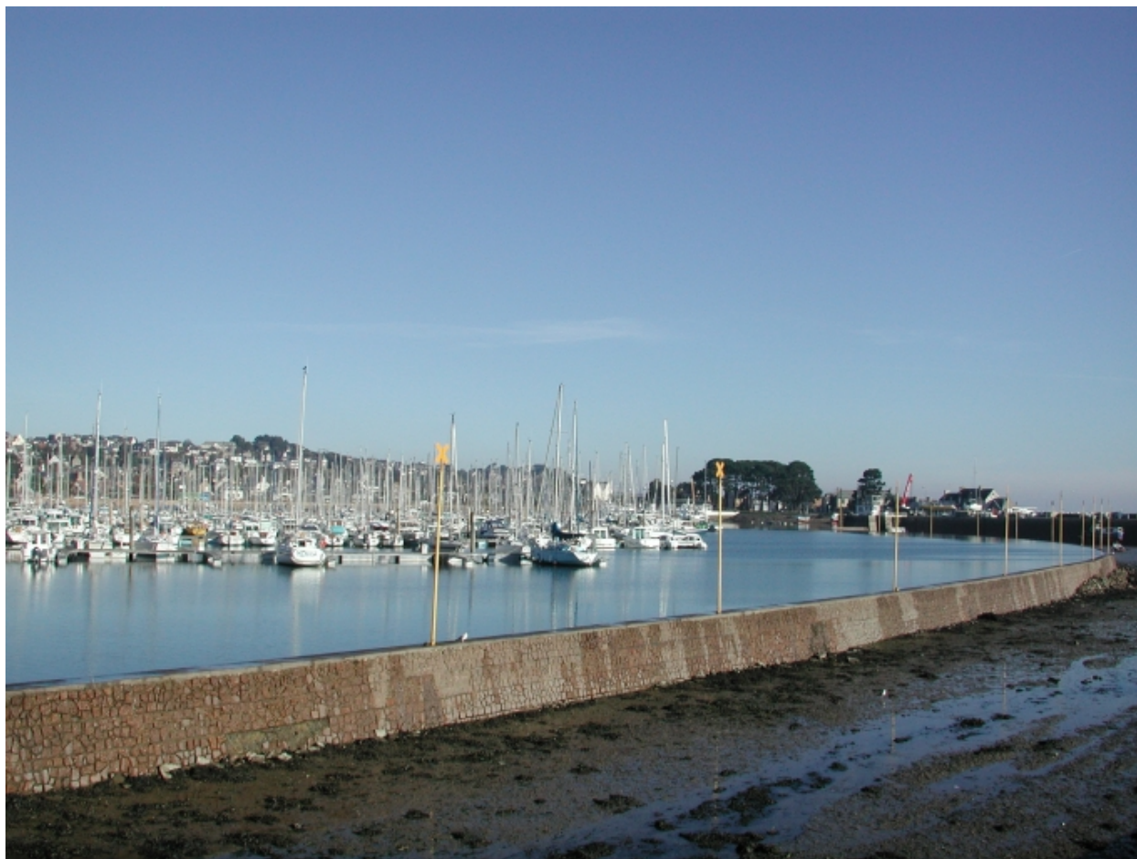
Le bassin à flot et son mur de retenue à grande marée basse
