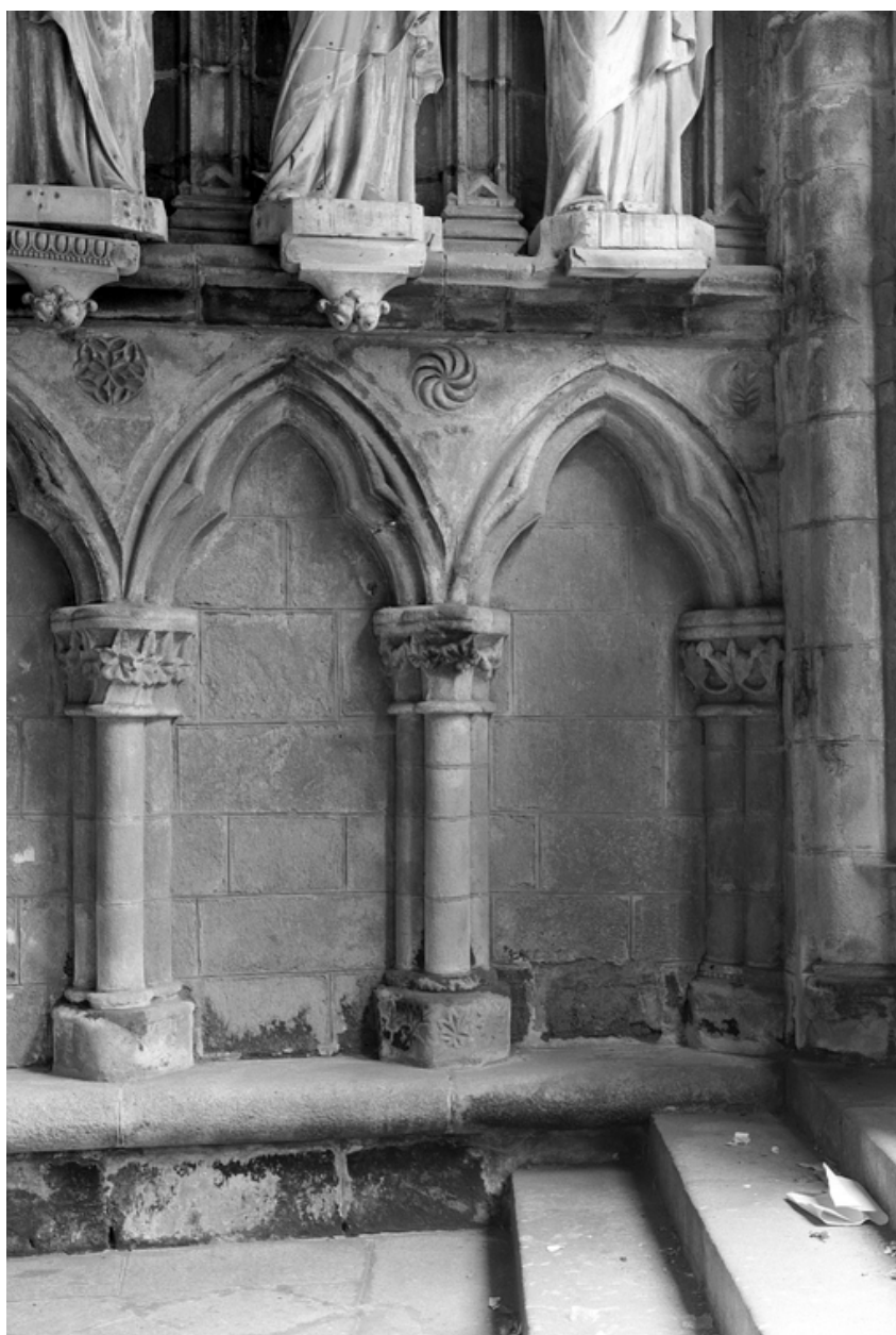
Porche sud, intérieur : mur est, détail des arcades 1 et 2 au sud
