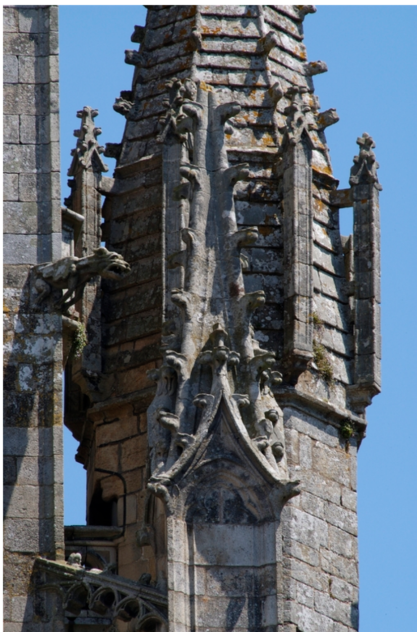
Clocher, détail du sommet de la tourelle d'escalier sud
