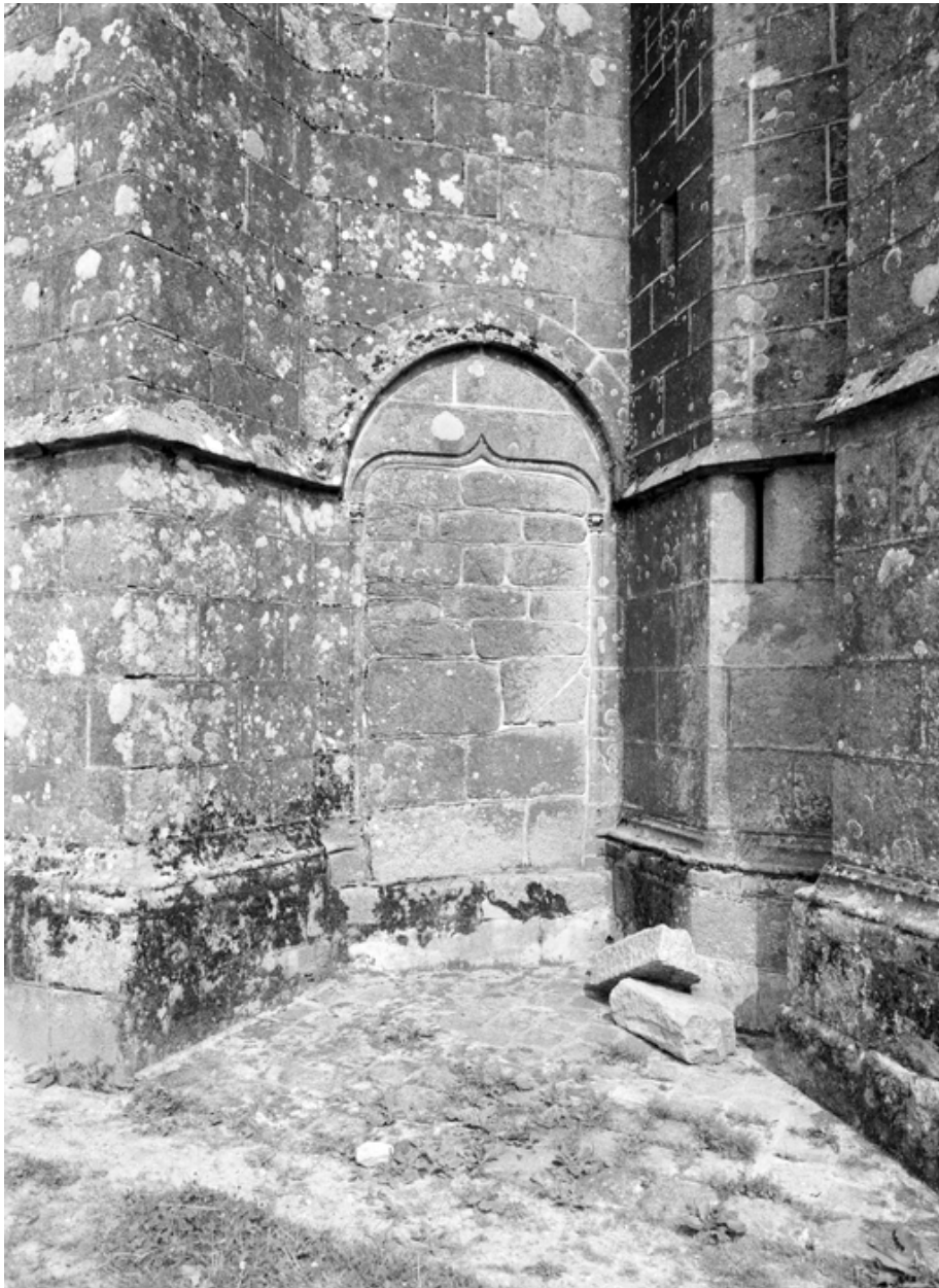
Porte murée du collatéral nord dans la façade ouest.
