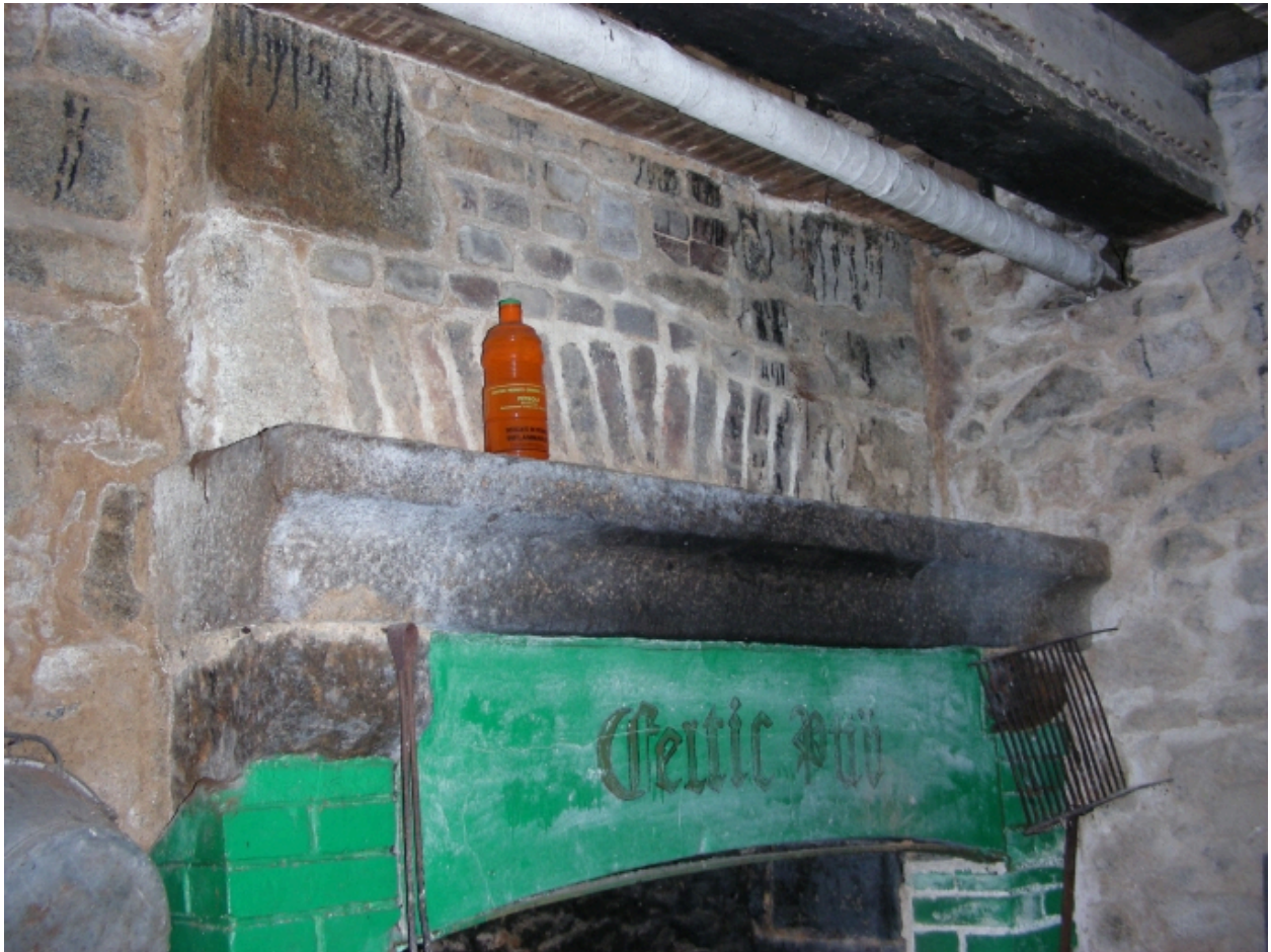
Cheminée dans la cave sous l'écurie
