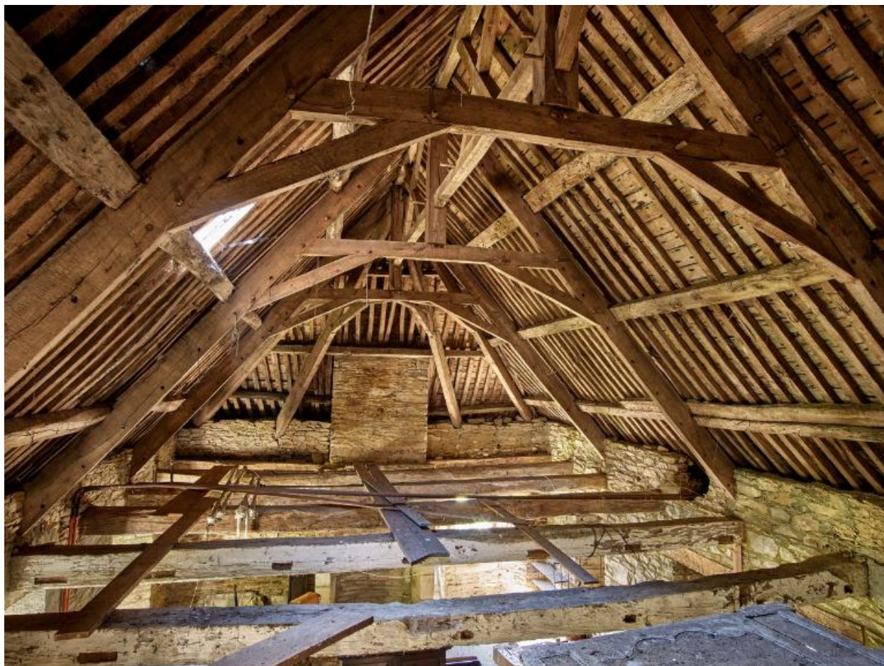
Logis. Charpente du comble, à entrain retroussé et poinçon court, double panne faîtière à croix de saint André. Vue générale ouest
