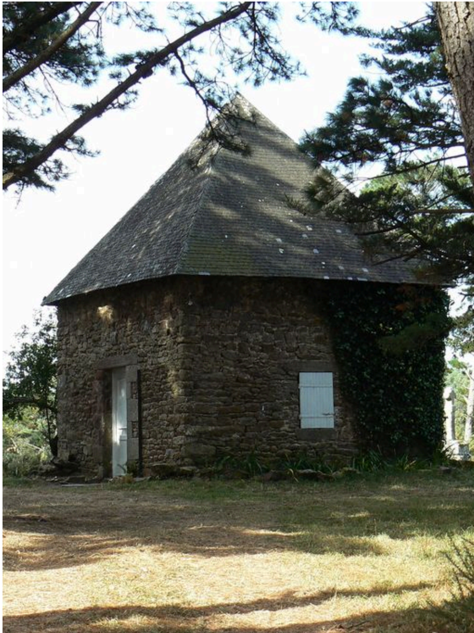
Guérite des douaniers de Barrarac'h
