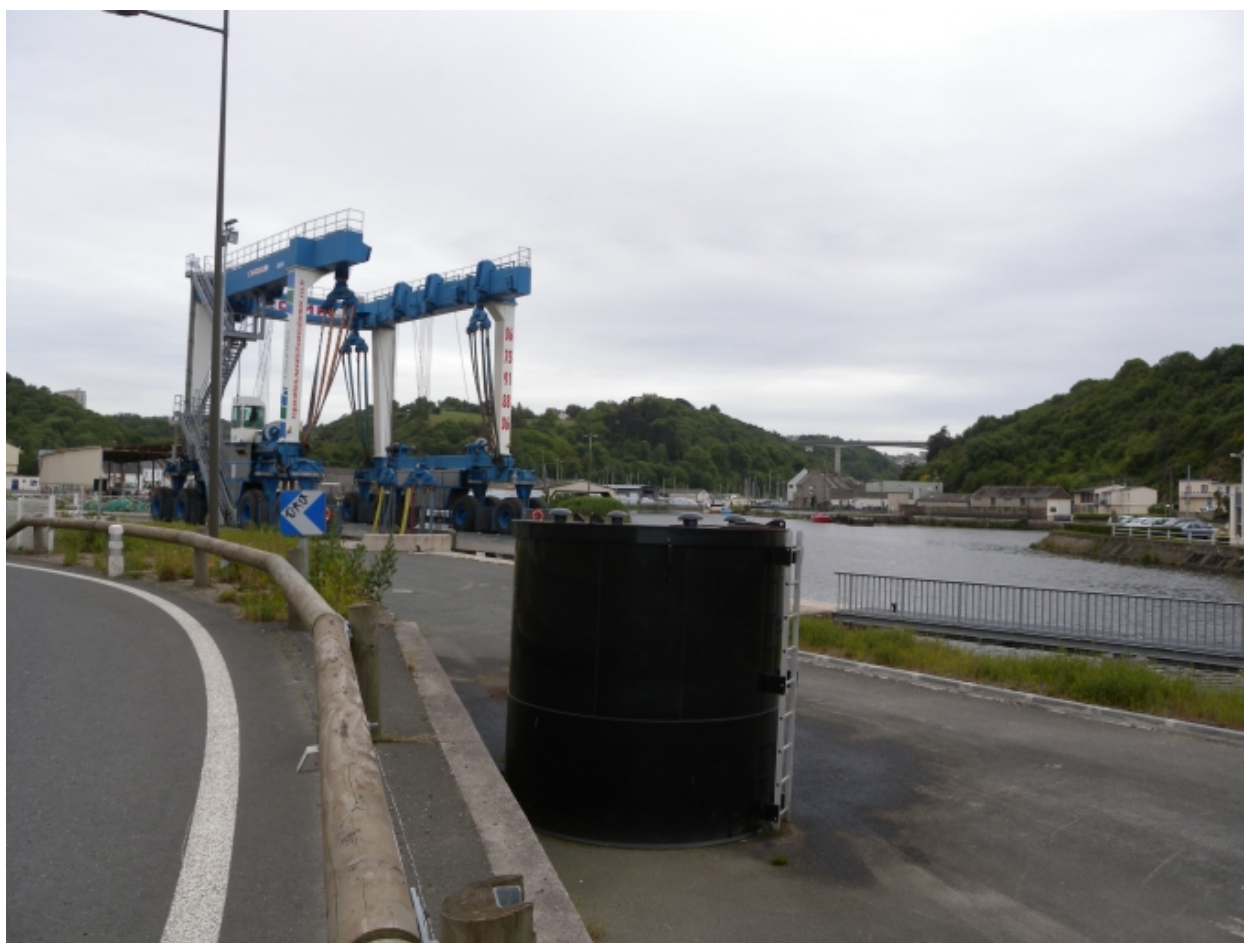
La nouvelle grue de 350 tonnes de charge à côté de l'ancienne voie de chemin de fer, quai Surcouf
