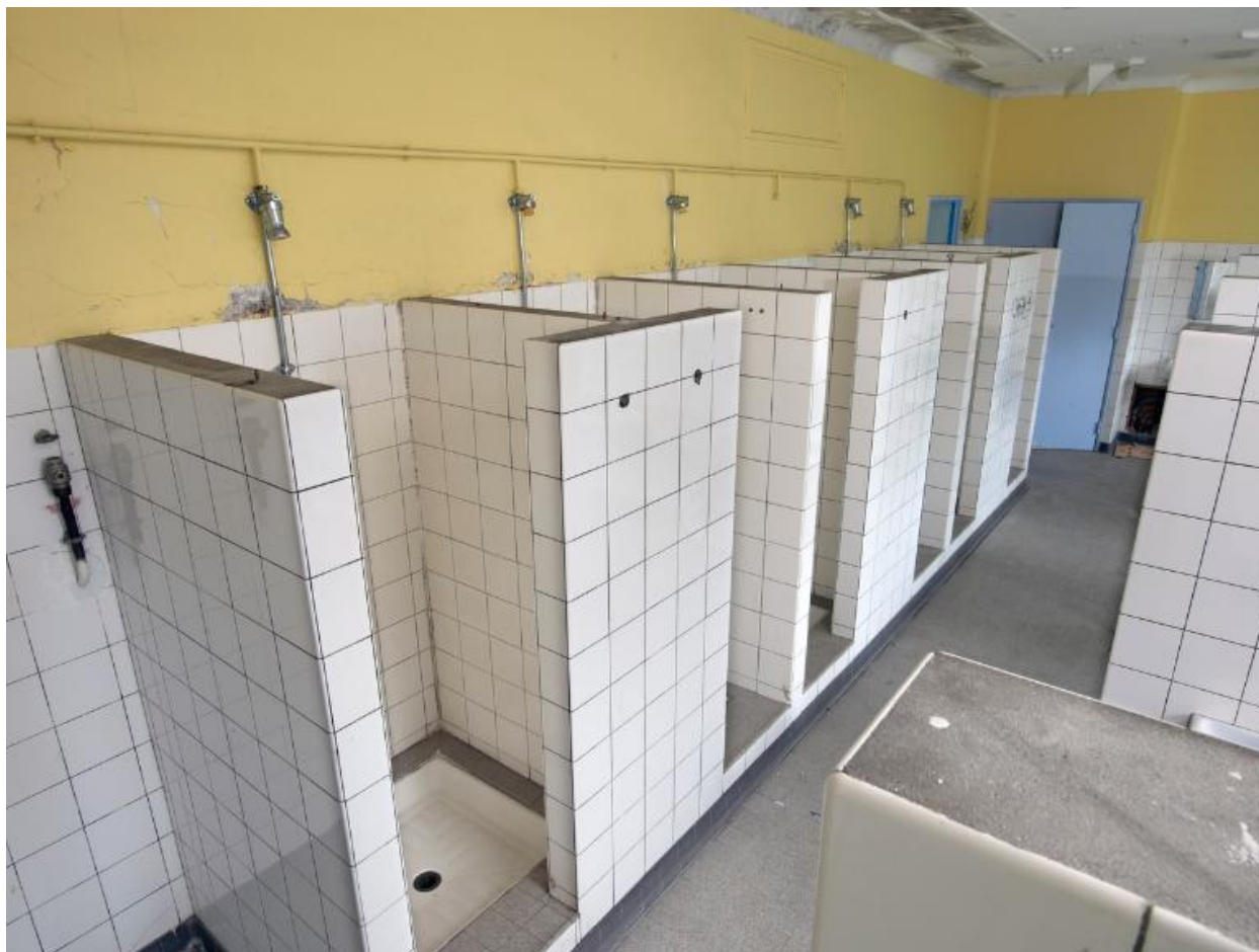
Douches et lavabos, internat de garçons (1954), désaffecté.
